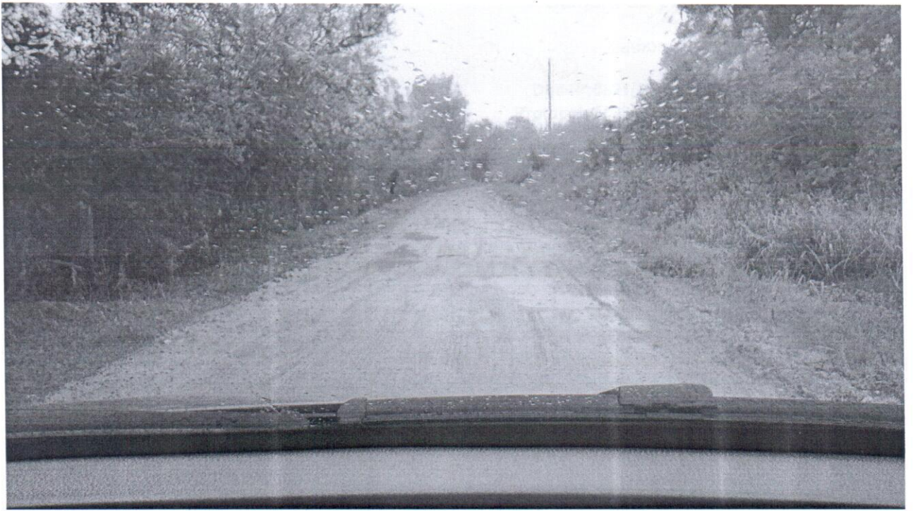
Bueiro próximo a residência Profª Noeli
