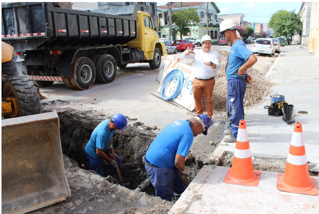
Troca de redes na Deodoro antes da via ser pavimentada.
