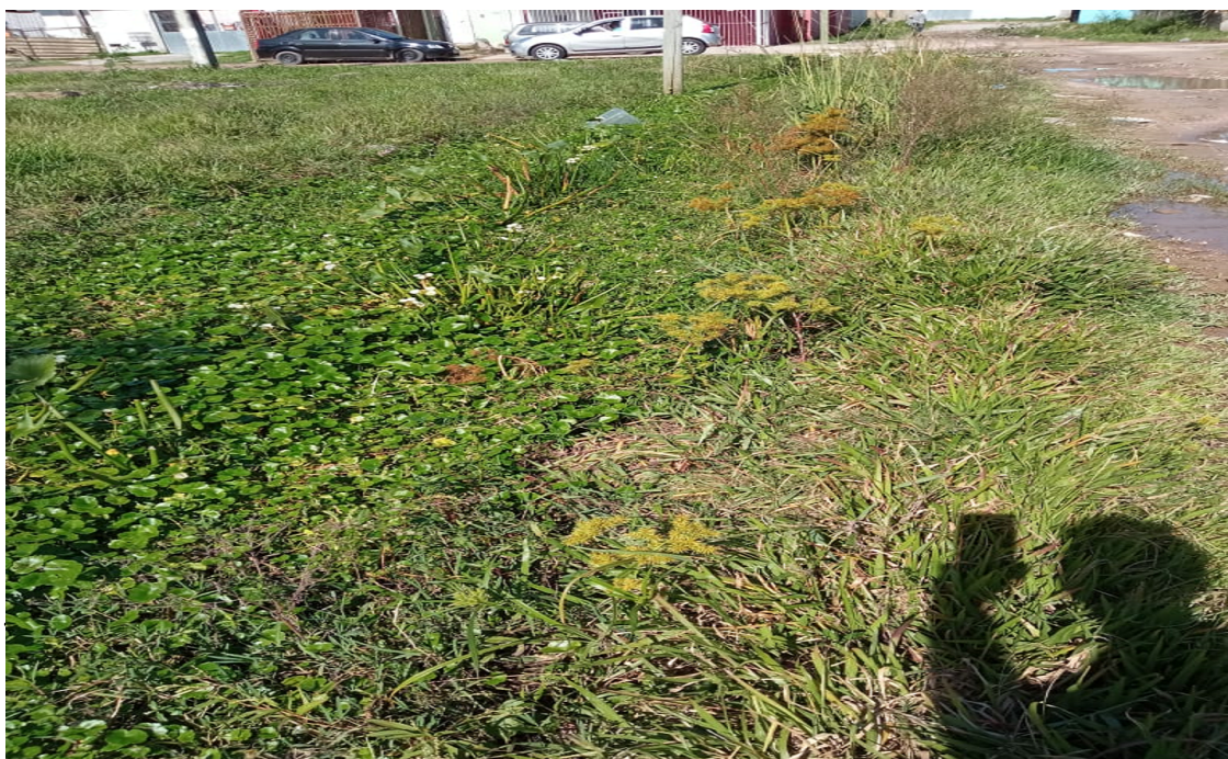
Figura 1; Canal de micro drenagem completamente tomando de vegetação e resíduos.
